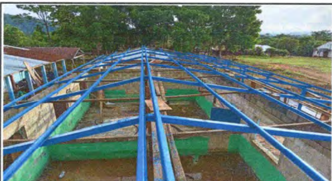
Foto 3: SUSTITUCION DE ESTRUCTURA DE TECHO.
