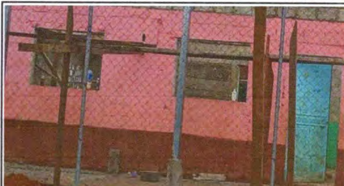
Foto 2: MEJORAMIENTO DE VENTANAS POR BALCONES DE METAL
