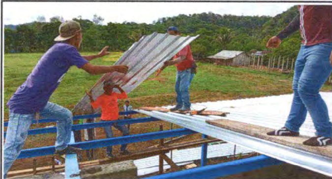
Foto1: SUSTITUCION DECUBIERTA DE LAMINAS.
